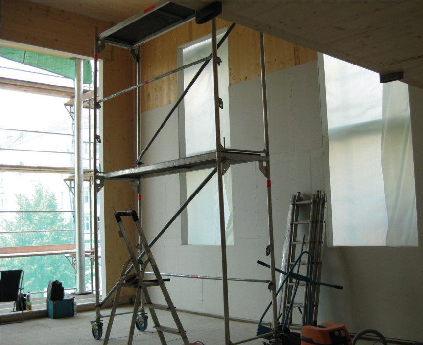
▲ Einbau Brandschutzverkleidung
