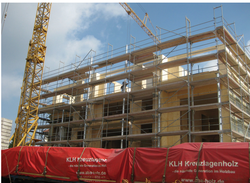
▲ Rohbauphase: pro Woche eine Etage
