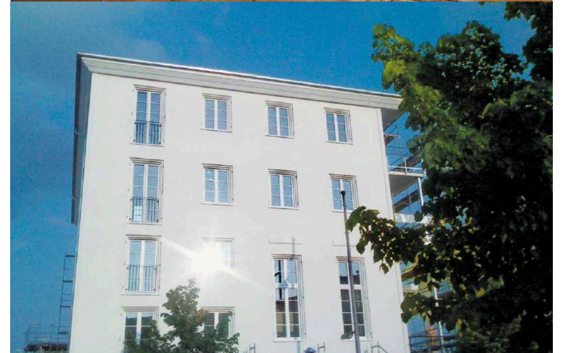
Dass die Berliner Häuser ganz aus Holz gebaut sind war nur dem Rohbau anzusehen – inzwischen ist alles hinter Putz und Rigipsplatten verschwunden
